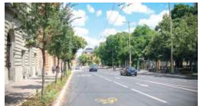
A vízvezetékcsere követően megújult a Stefánia útja és kerékpárútja.
