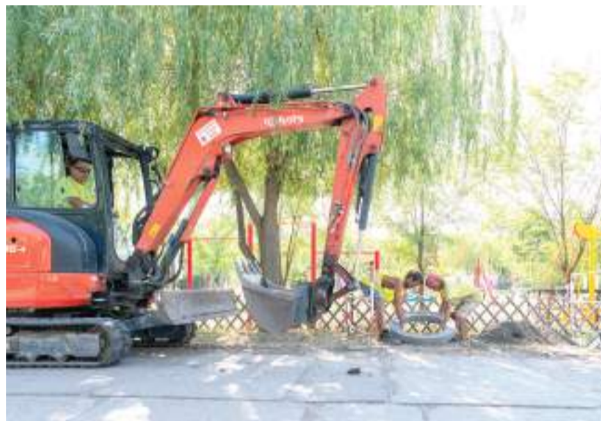
A kivitelező a Hosszútöltés út felújítását a csapadékvíz-elvezetés kialakításával kezdte el. Fotó: Iványi Aurél
